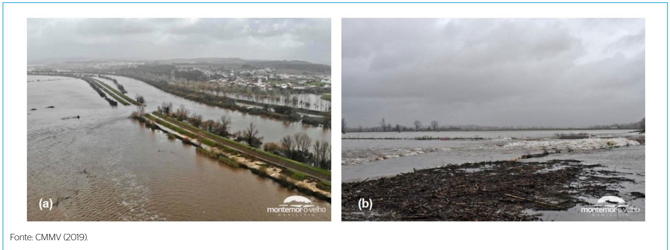
Figura 1 - Vista da (a) ruptura dos diques de proteção contra cheias do vale central do Rio Mondego e (b) inundação dos campos agrícolas no Baixo Mondego, em dezembro de 2019.
