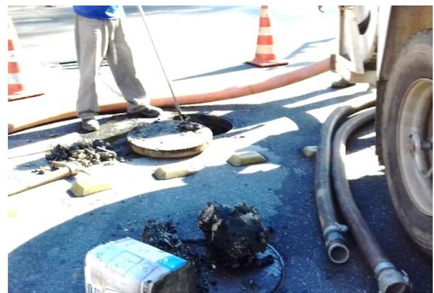
**Figura 2** – Manutenção da rede coletora mostrando acúmulo de material gorduroso.
