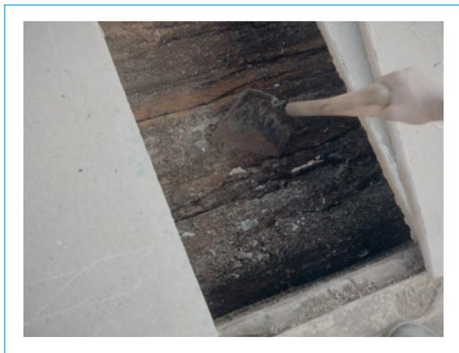
**Figura 5** - Escuma solidificada no reator UASB.
