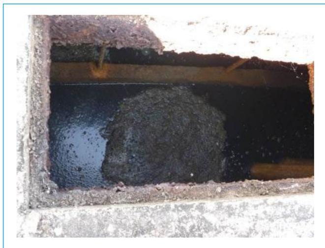
**Figura 4** - Escuma na unidade de decantação do reator UASB.
