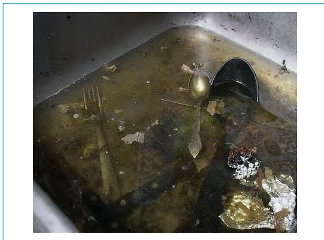
**Figura 1** – Entupimento de pia ocasionado por mau uso.
