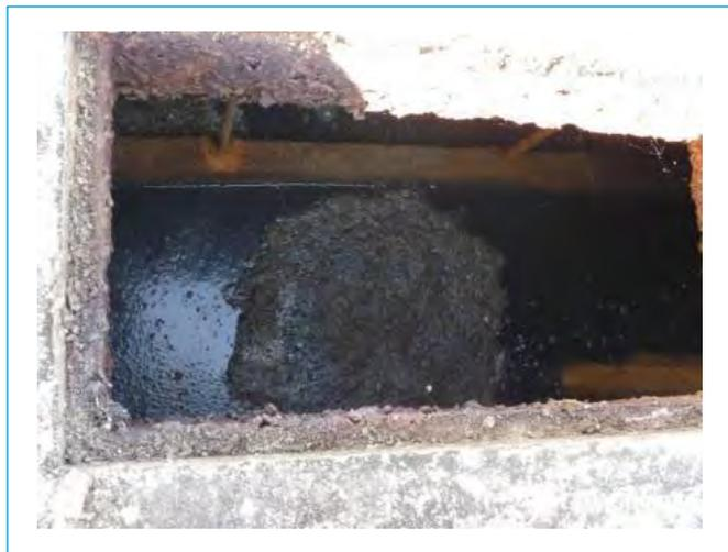
**Figura 4** - Escuma na unidade de decantação do reator UASB.
